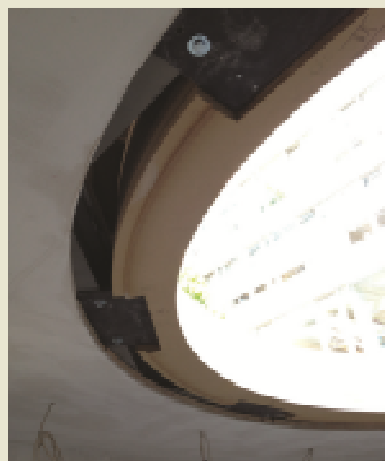
Ausbauphase. Das Bullaue selbst besteht aus MDF-Elementen, die mit Flanschen an der Stahlkonstruktion befestigt sind.
